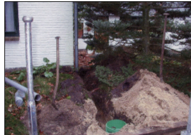
Foto 8. Aanleg particuliere infiltratievoorziening (Foto: Schoon uit het riool, RIONED 2001)
