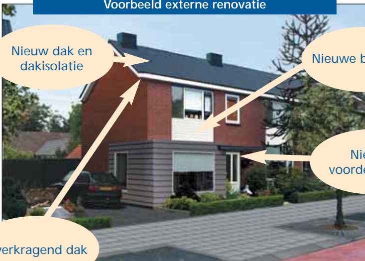
Voorbeeld externe renovatie
